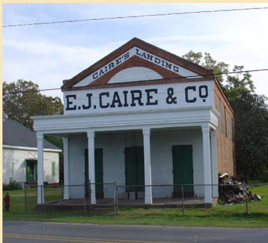
Magasin Caire, St John the Baptist, Louisiane (USA), restauré en 2006.
